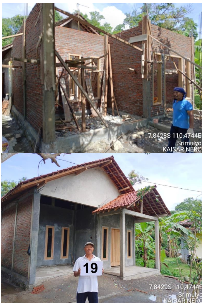
Gambar 29. Pembangunan Rumah Baru Layak Huni di Kalurahan Srimulyo
