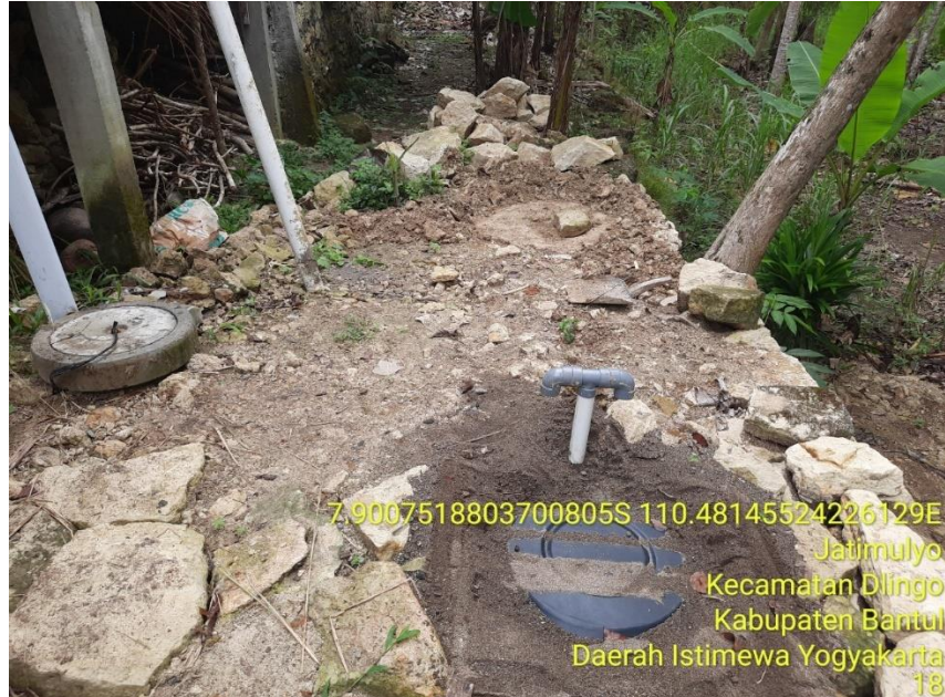
Gambar 20. Pembangunan Tangki Septik Individu di Jatimulyo, Dlingo
