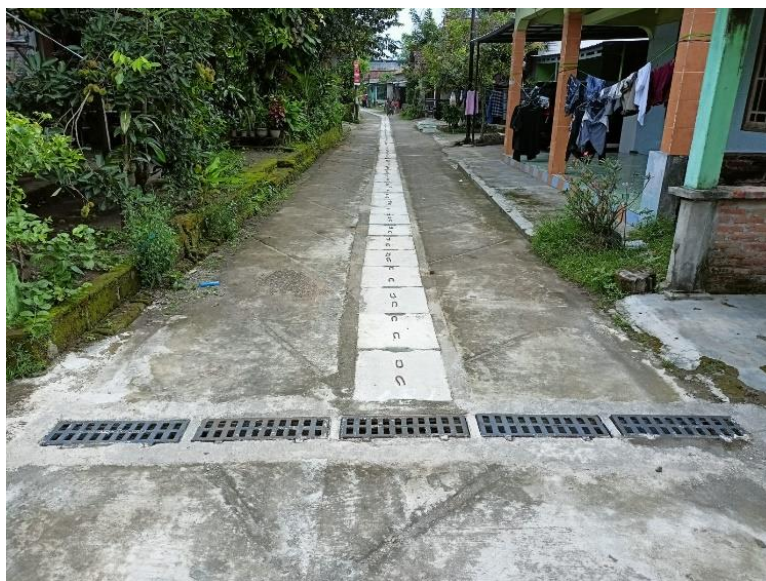
Gambar 24. Pembangunan Drainase Lingkungan di Ngaglik Pendowoharjo Sewon
