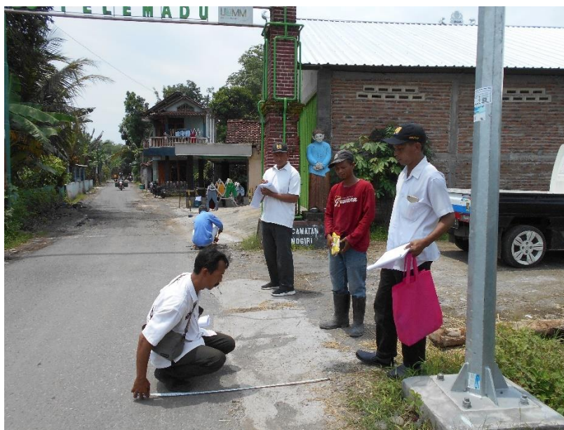
Gambar 17. Pembangunan SPAM Jaringan Perpipaan di Sriharjo
