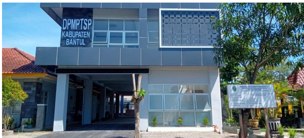
Gambar 7. Pembangunan Gedung Pelayanan DPMPT di Komplek 2 Perkantoran Pemkab Bantul
