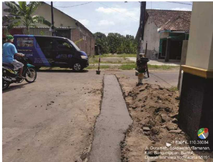
Gambar 16. Pembangunan SR SPAM Jaringan Perpipaan di Bawuran
