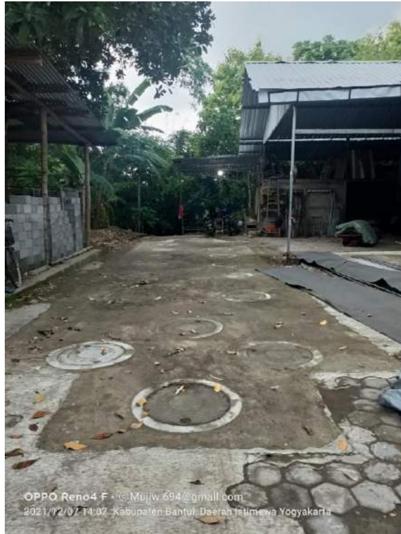
Gambar 18. Pembangunan SPALD-T Permukiman di Kapanewon Trimulyo
