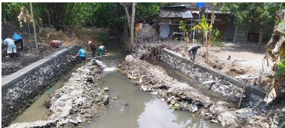
Gambar 10. Proses pembangunan Afvour Karangmojo di Kapanewon Bantul
