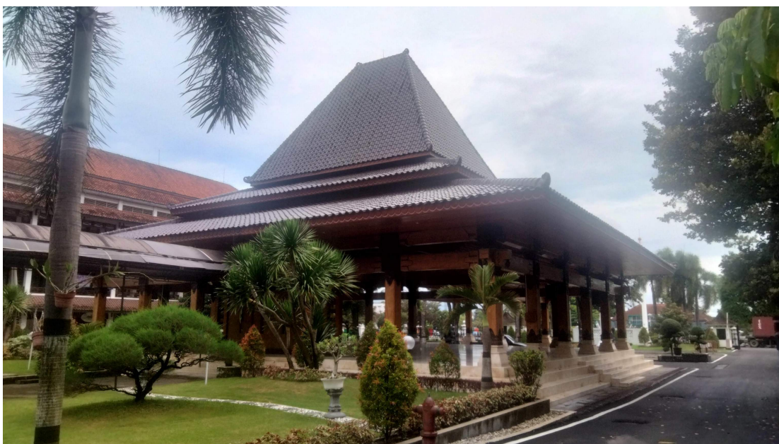
Gambar 8. Rehabilitasi Pendopo Parasmya di Komplek Kantor Bupati Bantul
