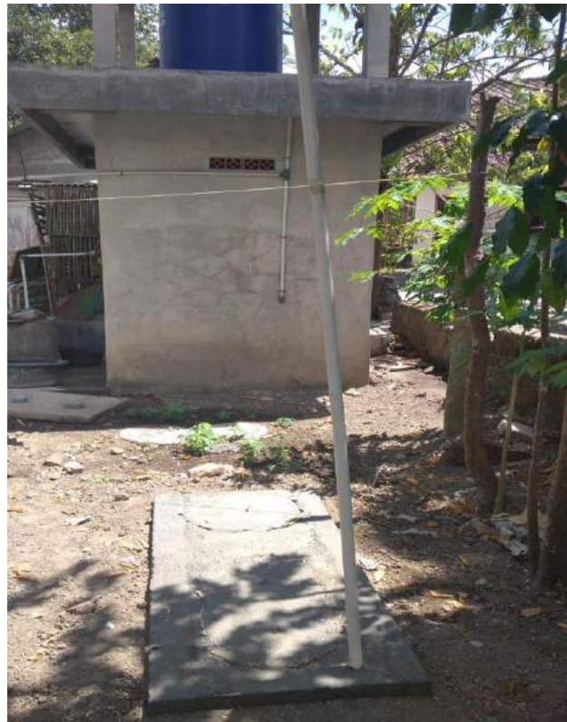
Gambar 17. Pembangunan Tangki Septik Individu di Paten, Sumberagung, Jetis
